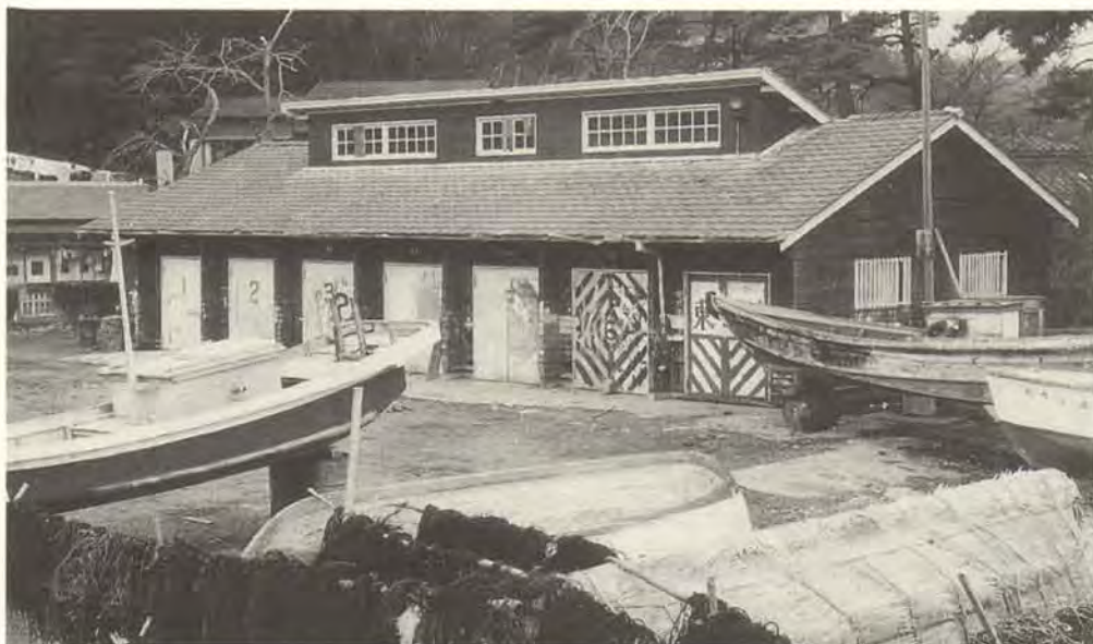
完成した県営ヨットハーバー艇庫
