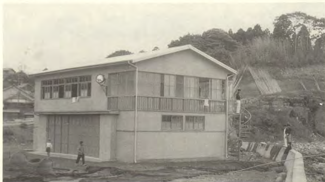
完成した総2階の艇庫
