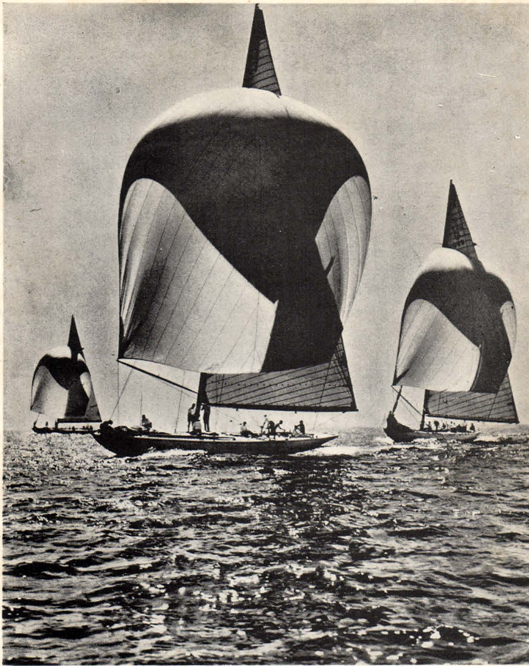
スピナーカーはできるだけ前方 に張り出して張る。(問題42の参考) 写真は国際12米級のレース
